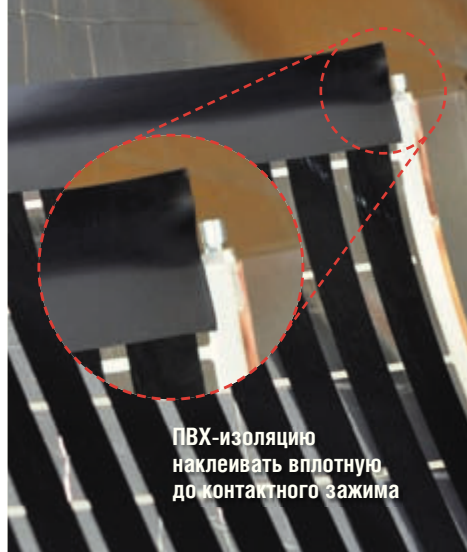
Рис. 11. Наклейка ПВХ изоляции на срез пленки
