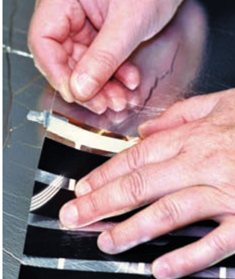
Рис. 8. Установленный на термопленку контактный зажим
