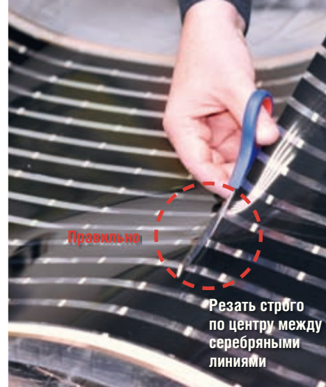
Рис. 7. Разрезание термопленки CALEO PLATINUM посередине между серебряными линиями, расположенными перпендикулярно медной шине
