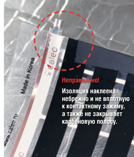
Рис. 13. Пример неправильной установки ПВХ изоляции
