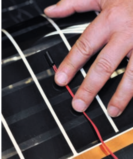
Рис. 22. Установка датчика температуры пола SF 4x15
