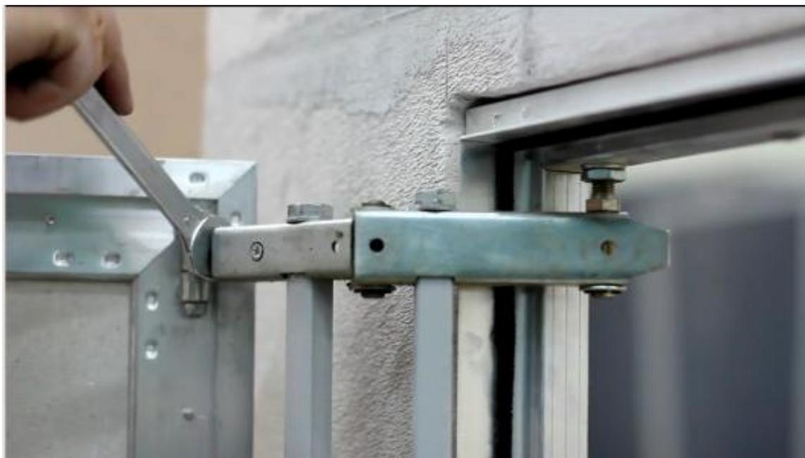
Выкручивая регулировочный винт - уменьшаем зазор со стороны пели, а закручивая - увеличиваем. Важно: подтягивая верхний винт, необходимо отпускать нижний на такое же количество оборотов. То же правило работает для регулировки наклона двери. Подтягивая или отпуская один из винтов - меняем угол наклона двери.
