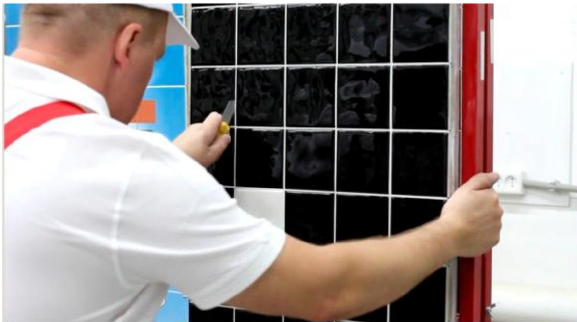
Открыть дверцу и удалить излишки герметика отовсюду, кроме боковых кромок плитки.
