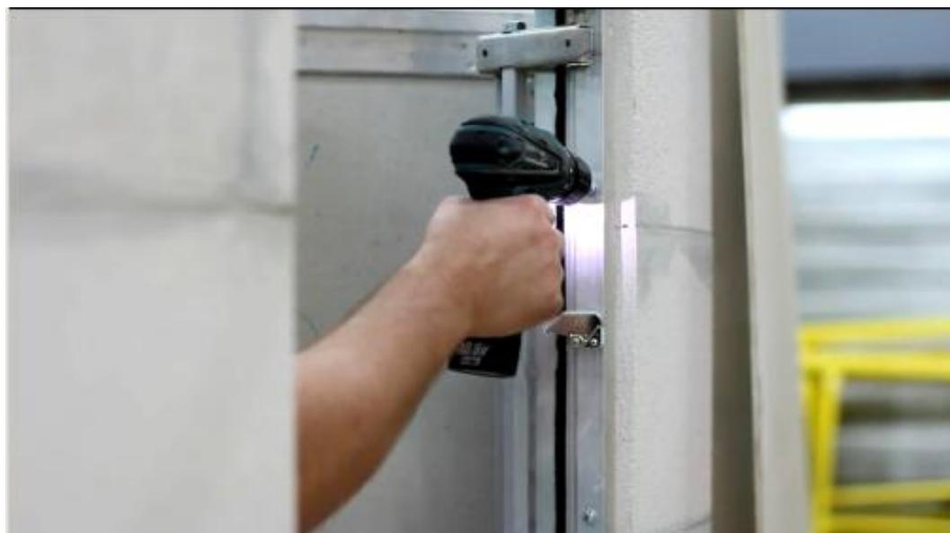
9. Оцениваем положение вертикальной плоскости рамы по **уровню**. При необходимости следует подтянуть или ослабить саморезы в вертикальной плоскости для изменения угла наклона рамы.
