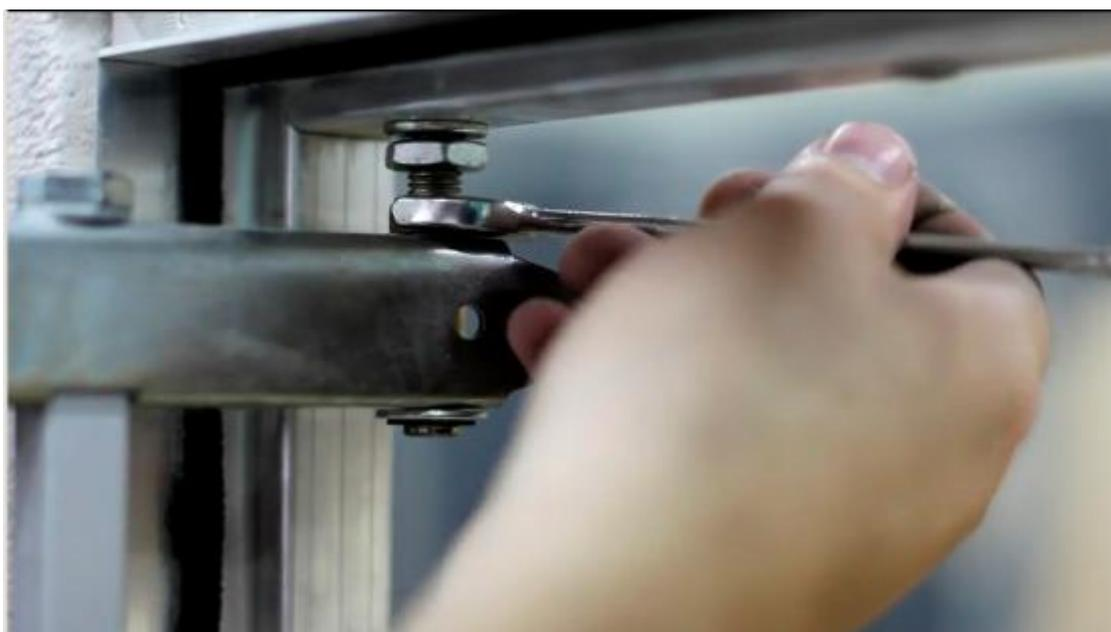
Отпускаем контргайку и производим регулировку по высоте. Важно: подтягивая верхний винт, необходимо отпускать нижний на такое же количество оборотов. После регулировки необходимо затянуть контргайки.
