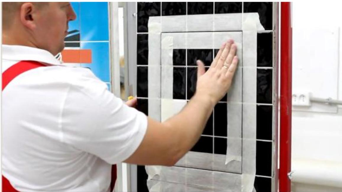
Силиконовый герметик наносится вовнутрь зазора по периметру двери люка слоем 1-1,5 мм.
