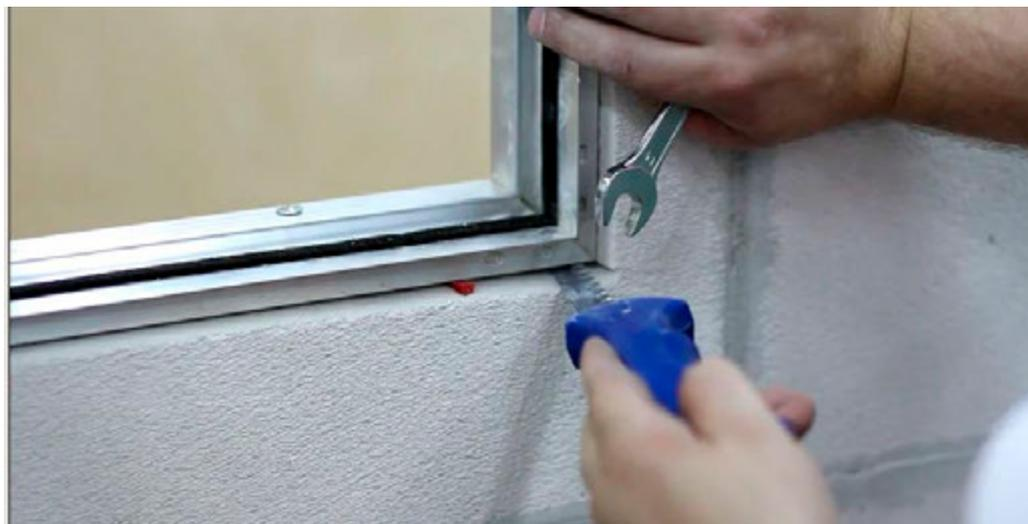
12. Регулируем зазор между дверью и рамой люка, глубину и угол наклона двери люка.
