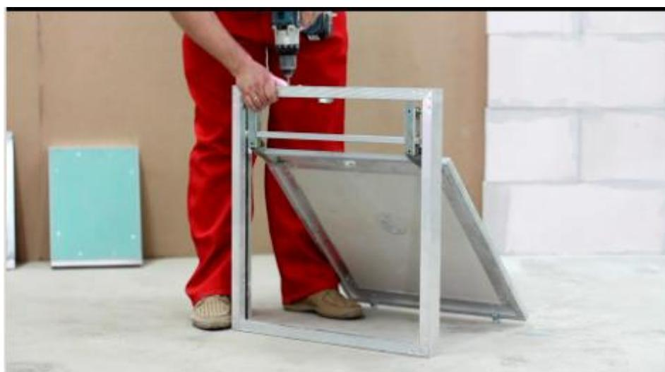
2. Помещаем люк в проем. Очень редко бывает так, что проем выполнен идеально. Чаще всего проемы неровные. Проверяем положение люка по уровню, выравниваем. Если необходимо, фиксируем в проёме на струбцинах.
