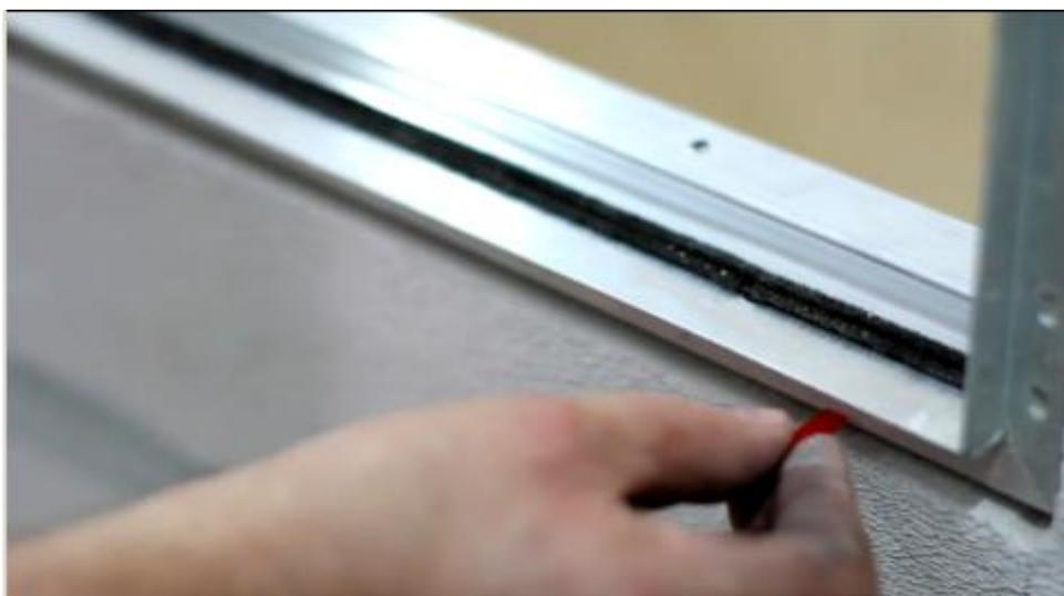
3. Через готовые отверстия в раме люка сверлим метки в ребрах проема для последующего крепления люка.
