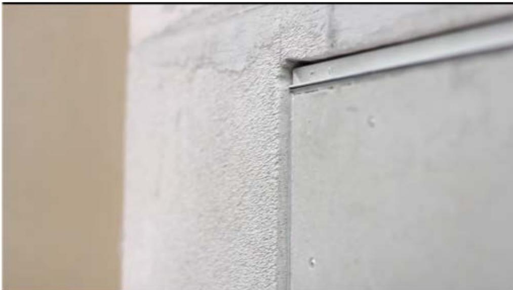
Подкладываем клинышки между проемом и нижней горизонтальной плоскостью рамы для возможности регулировки положения люка в дальнейшем.
