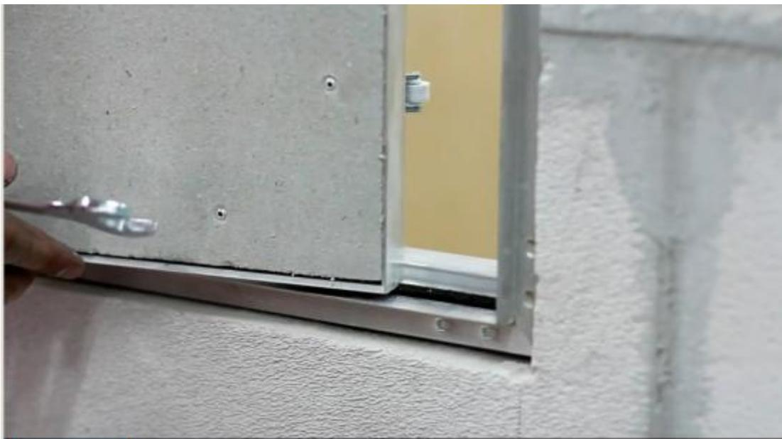
При правильной установке и регулировке зазоры между рамой и дверью люка одинаковые по всем сторонам и составляют 3-4 мм.
