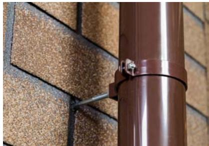
**13** Соединение водосточных труб между собой производится при помощи соединительной муфты, которая фиксируется на фасаде при помощи хомутов.
