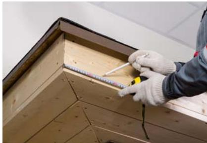
**2** Определите места установки водосливных воронок. Воронка может располагаться с края или по центру. Установите кронштейн на противоположной стороне карниза, соблюдая наклон. Одна воронка для системы 125/82 рассчитана на 50 кв. м, для системы МАКСИ — на 100 кв. м, но не менее одной воронки на скат.
