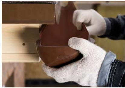
**9.1** Если угол поворота кровли не равен 90°, используйте угол желоба регулируемый, который состоит из двух элементов и подрезается по месту по отметкам угла поворота, заранее нанесенным на заводизготовителе. Соединение дополнительно герметизируйте.
