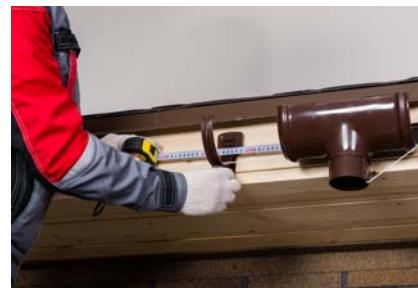
**3.1** Зафиксируйте кронштейны по всей длине карниза с шагом 500–600 мм, начиная от места установки воронки. Для системы МАКСИ 152/100 шаг установки кронштейнов 600–900 мм. Оптимально — 700–750 мм.
