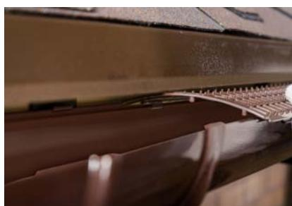
полнительных подрезов, расстояние между кронштейнами должно быть 600 мм.
