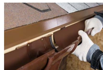
**5** Установите водосточные желоба в кронштейны до защелкивания с фиксирующими элементами кронштейна. Соединение желоба с кронштейном также необходимо производить в направлении «изнутри наружу».
