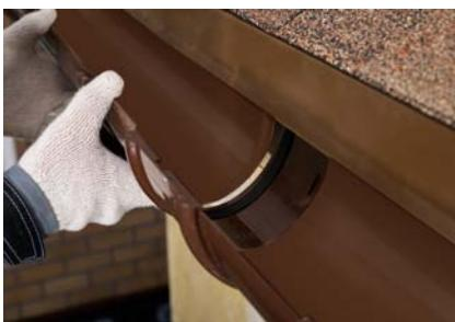
**7** В случае расположения воронки на краю карниза, чтобы закрыть воронку заглушкой, вам необходимо соединить воронку и заглушку отрезком из водосточного желоба. Распил желоба производите ножовкой с мелкими зубьями с последующей зачисткой среза напильником. Конец желоба в этом случае должен выступать за край кровли на 50–100 мм.
