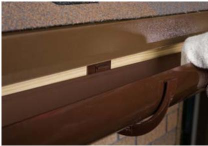
**6** При необходимости соединить два желоба установите соединитель желоба. Ближайшие к соединителю кронштейны установите с каждой стороны элемента на расстоянии 100–150 мм. Вставьте желоб в соединитель желоба до обозначенной линии. Соединение желоба с кронштейном необходимо производить в направлении «изнутри наружу».
