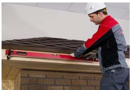
**2.1** Установите водосточную воронку напрямую к лобовой доске саморезами через специальные отверстия. В случае отсутствия лобовой доски воронку необходимо установить на удлинители кронштейна.
