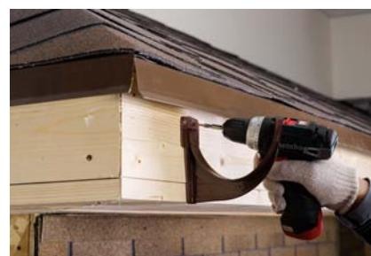
**2)** к стропильным ногам через удлинитель кронштейна прямой (применяется на этапе монтажа кровли); в случае, когда шаг кронштейнов не совпадает с шагом деревянных стропил, рекомендуется крепить прямой удлинитель кронштейна или металлический кронштейн в ОСП-3, заранее подготовив сплошное основание.
