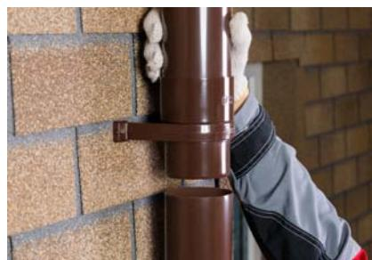
**14** Установите водосточный слив на трубу и зафиксируйте его хомутом. При этом минимальное расстояние слива от грунта — 200 мм, от отмостки — 150 мм.
