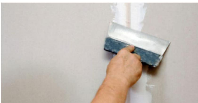
Рис. 8. Заделка швов
