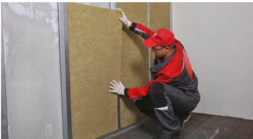
Рис. 12. Монтаж тепло-, звукоизоляционных плит
