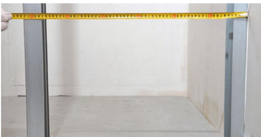
Рис. 4. Установка стоечного профиля
