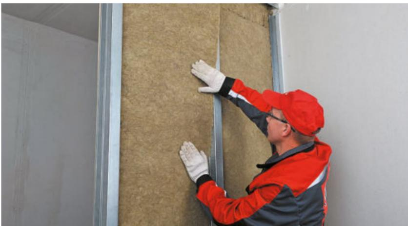
Рис. 6. Монтаж тепло-, звукоизоляционных плит
