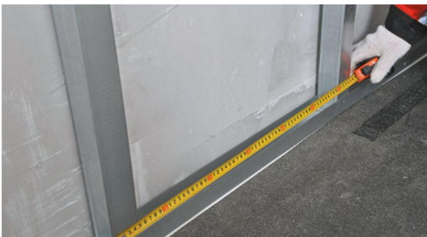
Рис. 11. Установка направляющего и стоечного профилей
