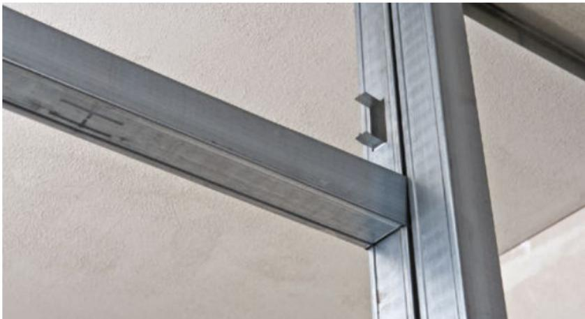
Рис. 4. Установка стоечного профиля (продолжение)
