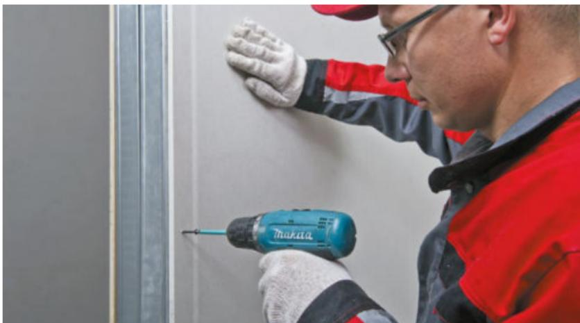
Рис. 13. Обшивка стен листами ГКЛ
