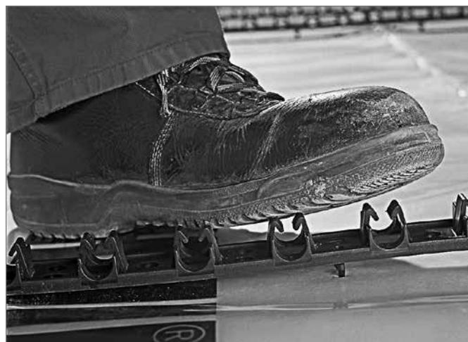
Рис. 21-46 Вдавливание фиксирующих шин RAUFIX в конструкцию пола
