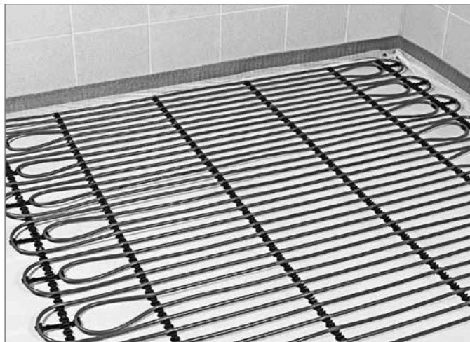
Рис. 21-67 Напольная фиксирующая шина для «мокрого» способа монтажа
