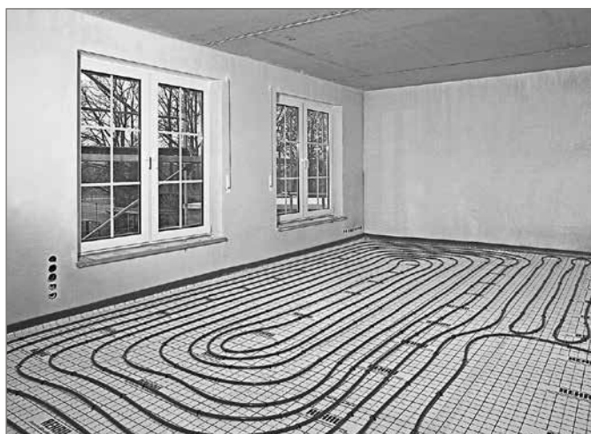
Рис. 21-33 Система крепления труб с помощью гарпун-скоб
