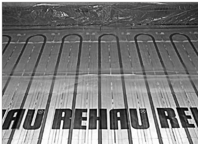
Рис. 22-1 Система укладки труб на теплоизоляционных матах TS-14
