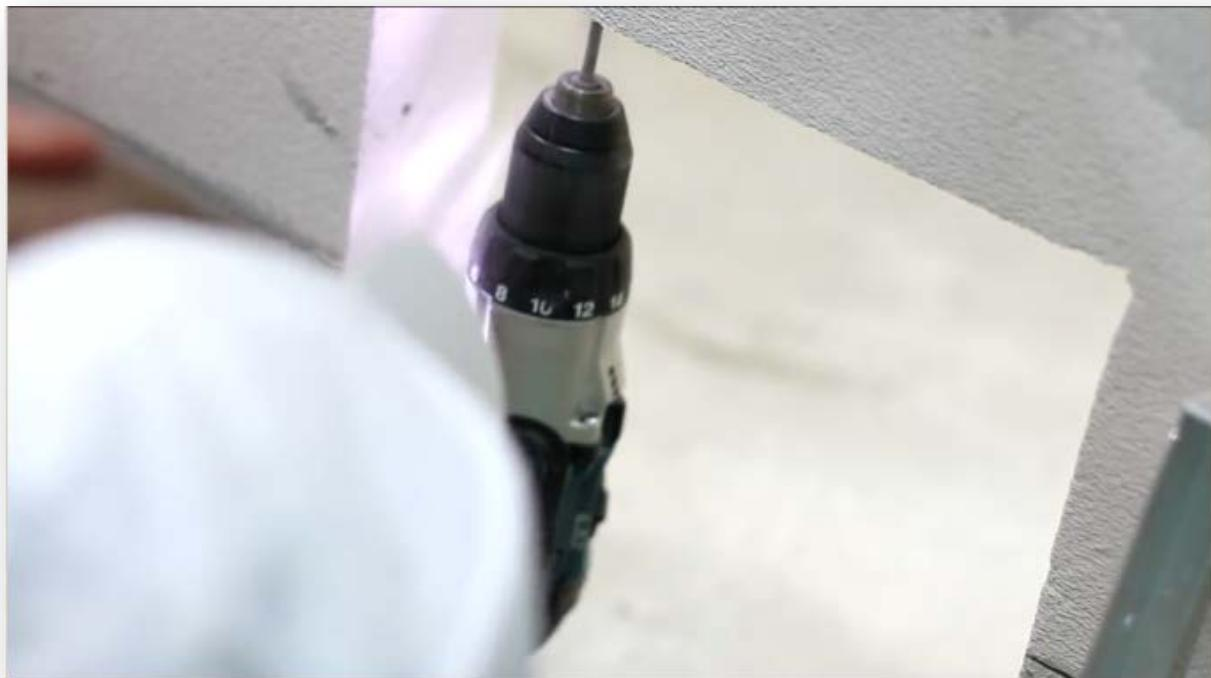
5. Забиваем дюбели в отверстия, просверленные в ребрах проема.
