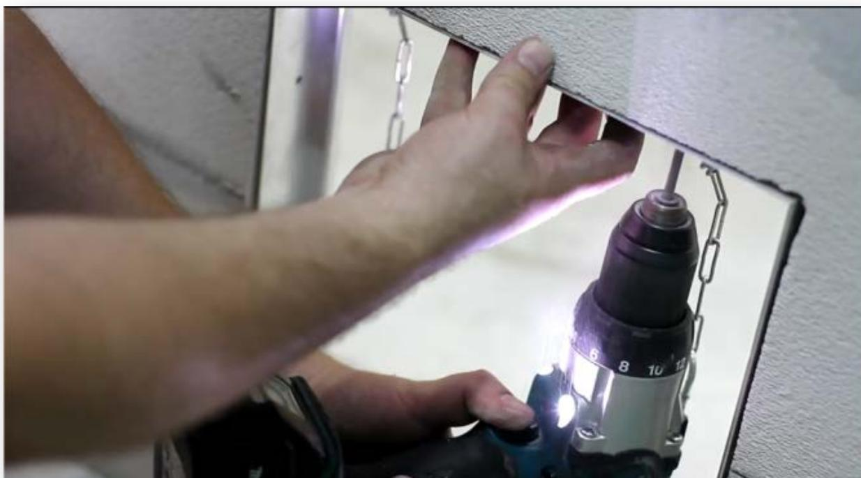
4. Вынимаем раму из проема. По нанесенным меткам сверлим отверстия в ребрах проема.
