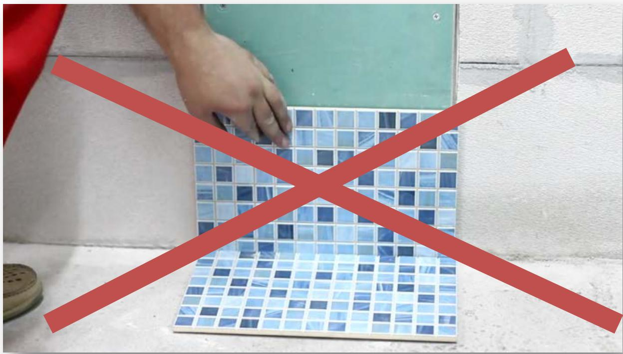
**Неправильная укладка плитки ведёт к потере отделочных материалов, потере функционала люка, дополнительным затратам на переделку!**
