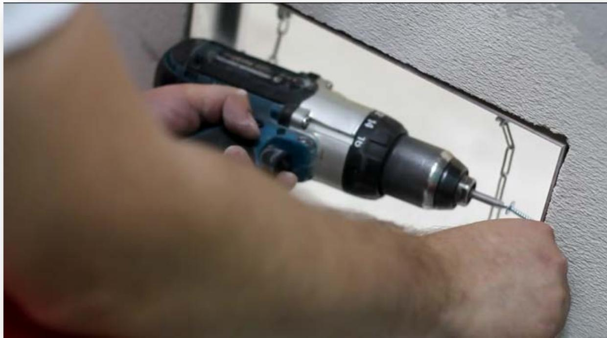
Редко бывает так, что проем для установки люка подготовлен идеально. Нормальная ситуация, когда в процессе инсталляции между ребрами проема и рамой остаются зазоры. Они устраняются в процессе отделочных работ. **Важно не перетянуть саморезы!**
