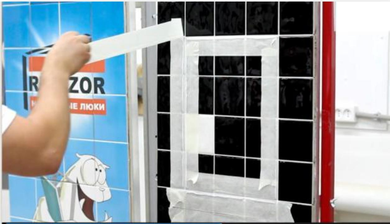
10. Прорезать проем дверцы острым ножом. Нож следует держать под углом 30-40 градусов, с наклоном лезвия в сторону внутренней части двери люка. Прорезать следует так, чтобы отделяемая часть герметика оставалась на ребре плитки люка, а не на ребре плитки закрывающей раму.
