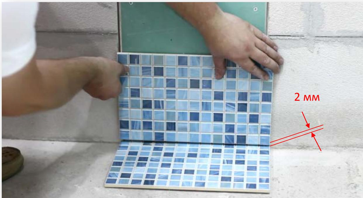
Лучшие варианты клея - клей для плитки либо "жидкие гвозди". Ни в коем случае нельзя клеить плитку на дверь люка на силиконовый герметик! Герметик эластичен, при высыхании пружинит, это приводит к тому, что высыпается затирка между плитками.
