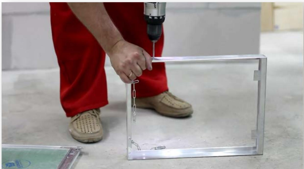
3. Помещаем раму люка в проем, таким образом, чтобы внешнее ребро рамы было заподлицо с плоскостью стены, на которой будут отделочные материалы.
