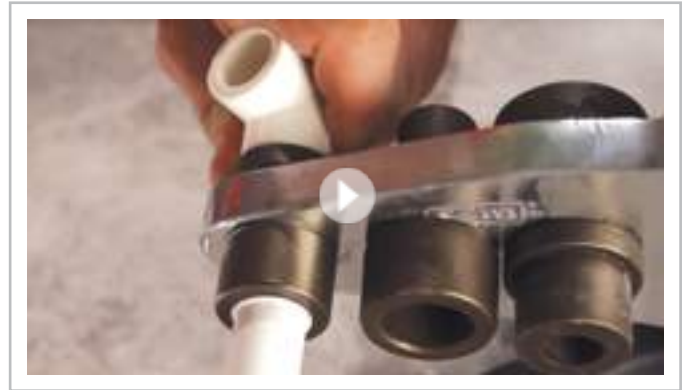
Монтаж полипропиленовых труб.
