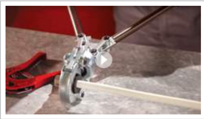
Монтаж металлопластиковых труб.
