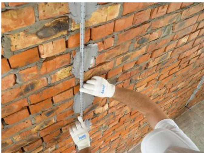
Вдавливаем маячковые профили в растворную смесь КНАУФ-Ротбанд и выравниваем их в одной плоскости.
