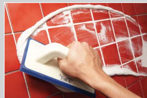
Нанесение LITOSCHROM 1-6 резиновым шпателем
