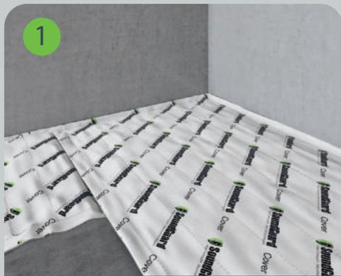
Звукоизоляционный материал SoundGuard Cover раскатывается на очищенное от мусора межэтажное перекрытие с нахлестом друг на друга примерно на 10 – 15 см, а также на стены на толщину стяжки.
