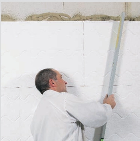
Выравнивание поверхности плит утепления
