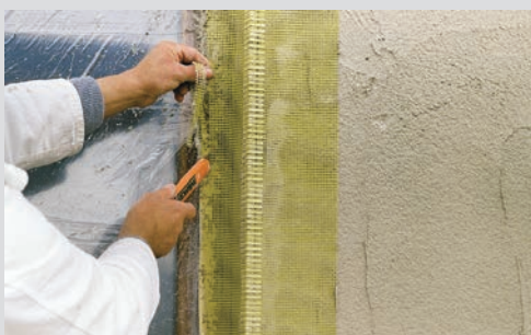
Установка углового профиля
