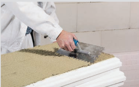
Нанесение штукатурно-клеевой смеси вручную, в случае ровного основания
