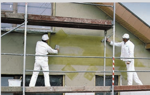
Армирование поверхности
