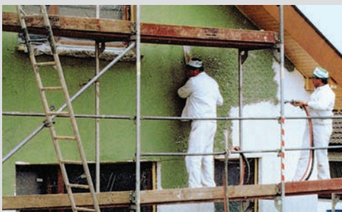
Нанесение раствора КНАУФ-Север
