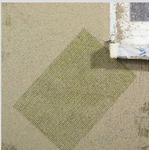
Армирование на углах оконного проема
