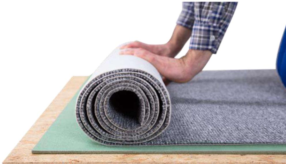
Раскатайте рулоны ковролина в помещении, где планируется укладка, и дайте отлежаться в течение 24 часов, чтобы материал расправился под собственной тяжестью.
