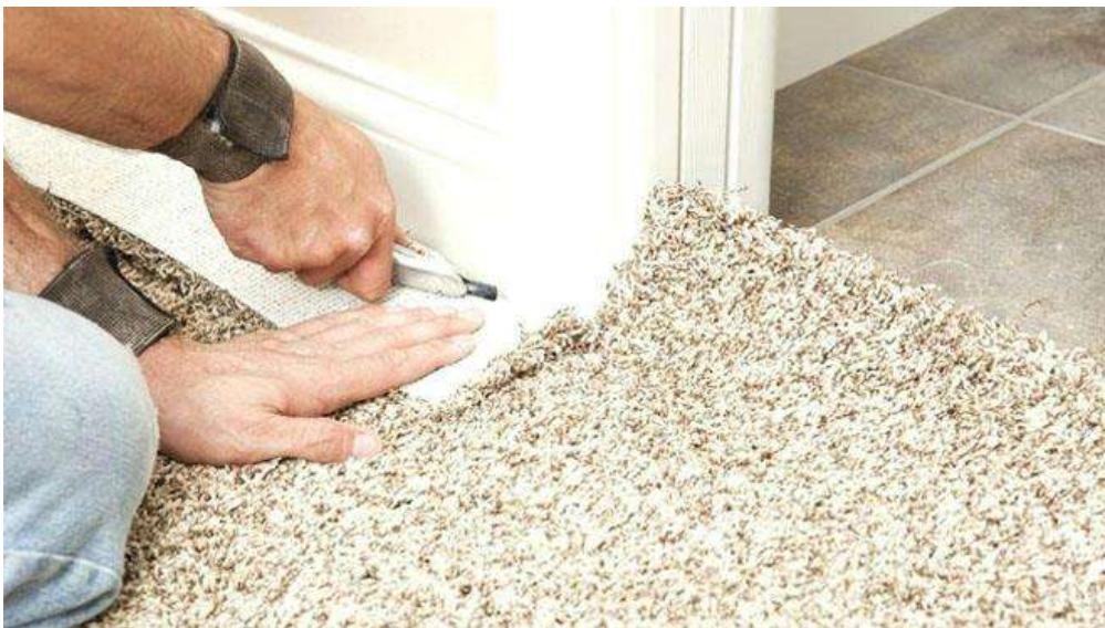
Обход препятствий — труб отопления, колонн, выступов стен:
